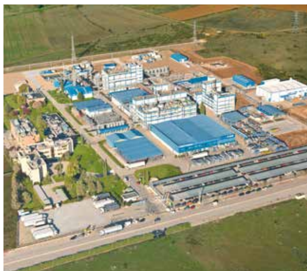
Centro de BASF en Marchamalo (Guadalajara), dedicado a la fabricación de pinturas para la automoción.
